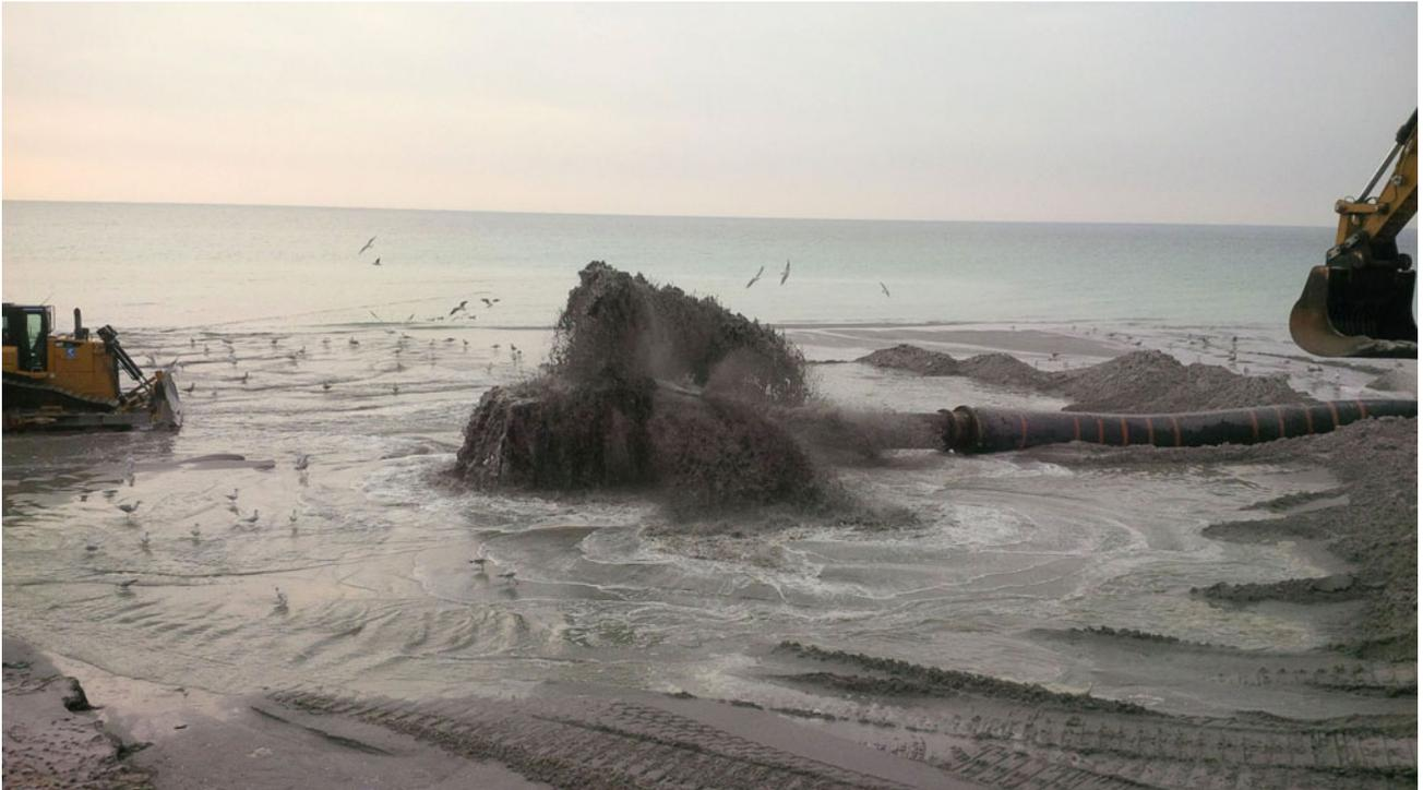
**Abbildung 1.15:** Der aufgespülte Sand wird durch die Maschen des Spülkorbs gedrückt. Dabei werden Objekte größer als 12 mm zurückgehalten (Foto: MBD M-V, 2015).
