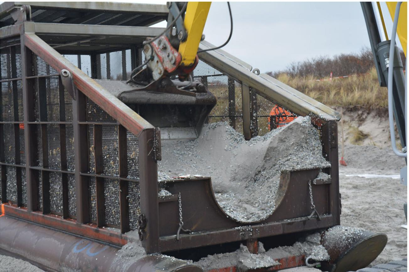
**Abbildung 1.18:** Nach dem Spülvorgang wird der Kasten abgezogen und mittels Kleinbagger entleert. Der entnommene Sand wird sorgfältig mit Metallsuchgeräten auf Kampfmittel überprüft (Foto: MBD M-V, 2015).
