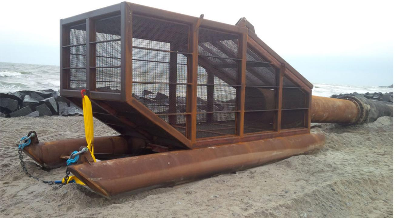
**Abbildung 1.17:** Der auf Kufen aufgebaute Siebkasten wird am Ende der Rohrleitung montiert (Foto: MBD M-V, 2015).
